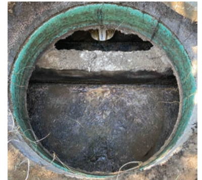
Niveau d'eau normal dans une fosse septique
