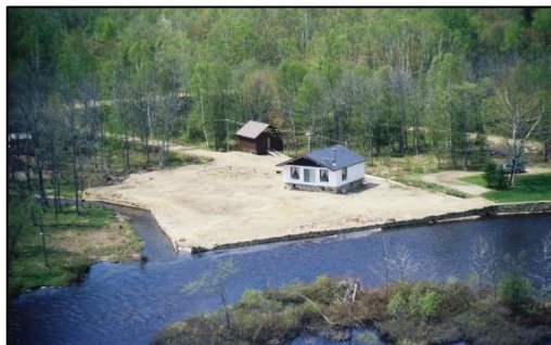
Figure 3.14 : Enrochement le long d'un terrain privé (à gauche) et Artificialisation d'une rive de la rivière Mastigouche (à droite)
