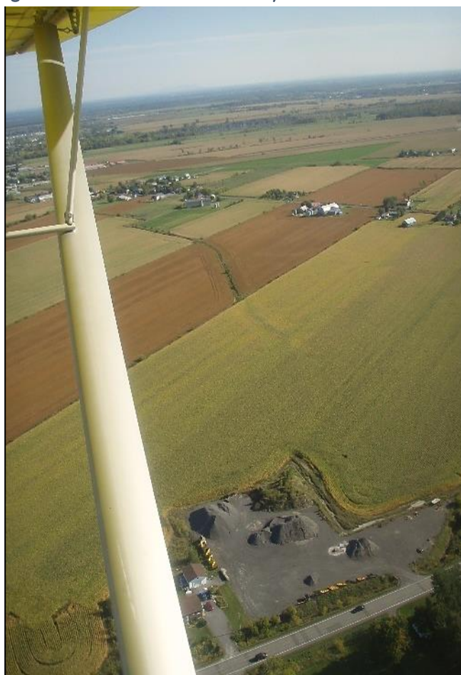
Figure 3.13 : Remblai d'un cours d'eau en milieu agricole dans la MRC de D'Autray
